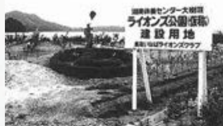
ライオンズ公園(老人憩いの森)建設
